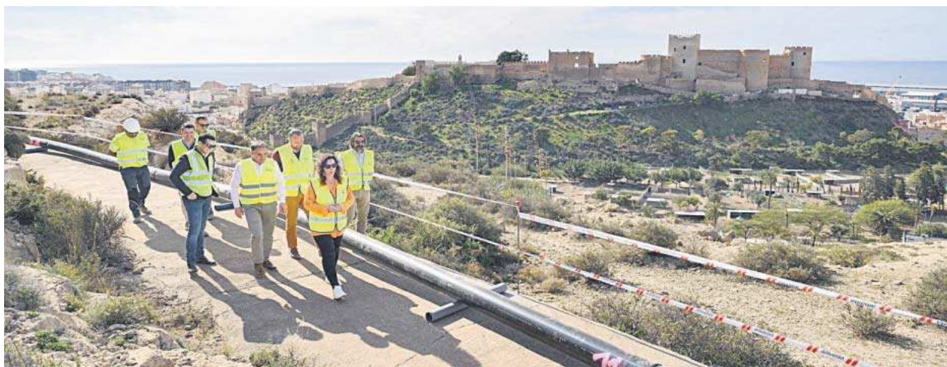
La alcaldesa y el concejal de Aguas, junto a técnicos, en su visita a las obras.
