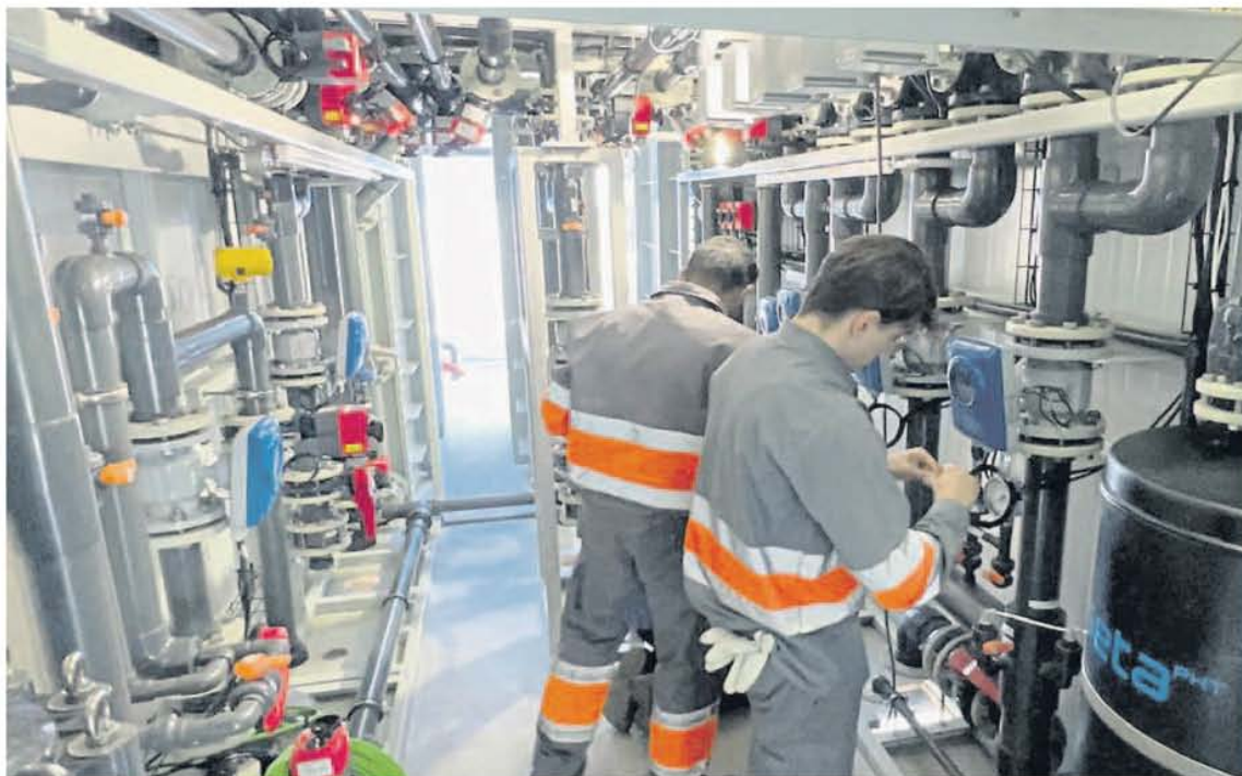
Unos operarios trabajan en una planta desalinizadora instalada en un contenedor
