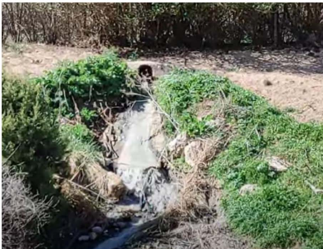
Vertido de agua sin depurar a la rambla.
